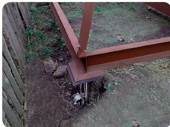
Винтовые сваи выдерживают значительные выдергивающие усилия. Однако широкое внедрение в строительную практику стальных винтовых свай позволило гарантированно обеспечить восприятия фундаментом необходимых нагрузок. При этом, допустимую на такую сваю нагрузку, можно повысить за счет увеличения диаметра лопасти и количества витков. Основными преимуществами СВФ для ЛЭП перед традиционными фундаментами являются:
